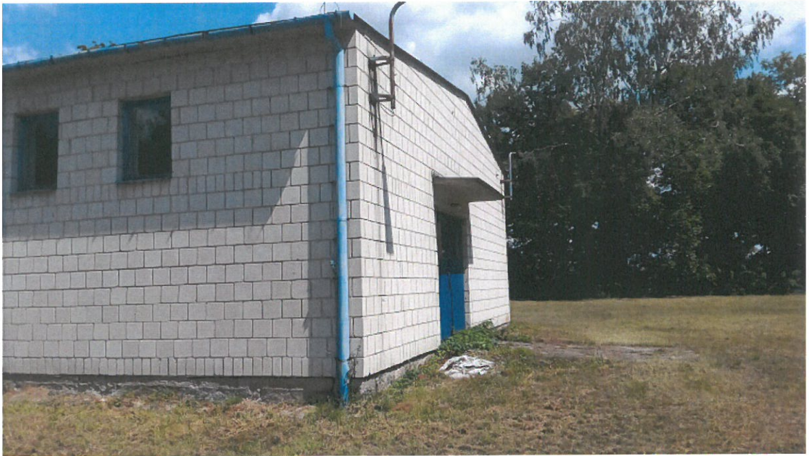
Zdjęcie nr 23 – Budynek SUW.
