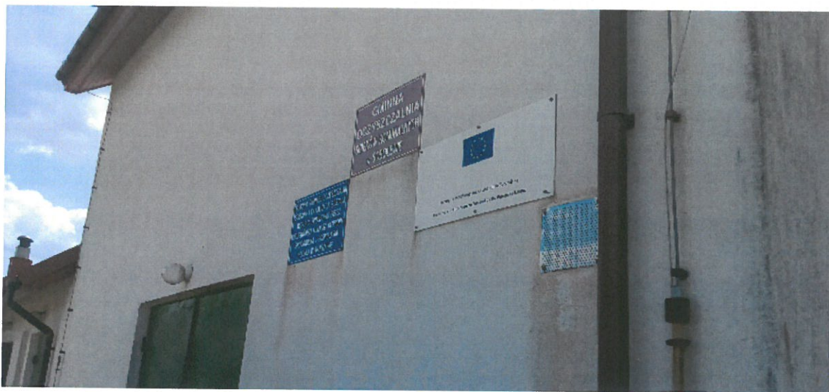
Zdjęcie nr 36 – Budynek oczyszczalni ścieków.
