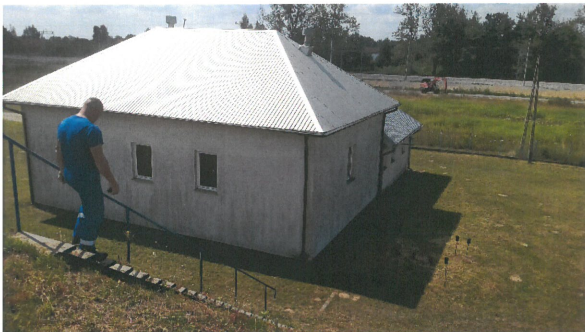
Zdjęcie nr 1 – Budynek SUW.
