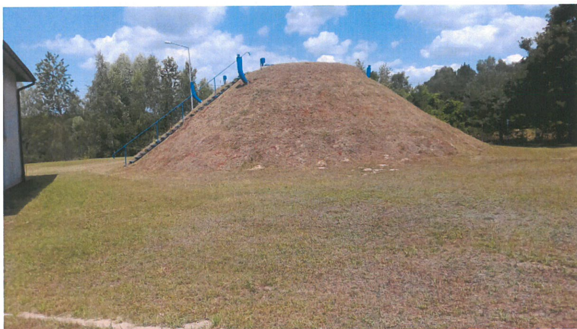
Zdjęcie nr 7 – Zbiorniki retencyjne.
