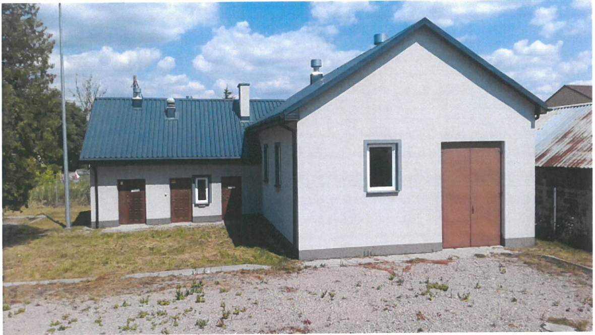
Zdjęcie nr 8 – Budynek SUW.
