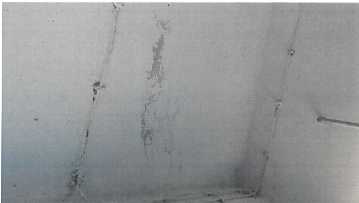
Zdjęcie nr 21 – Wnętrze budynku SUW.
