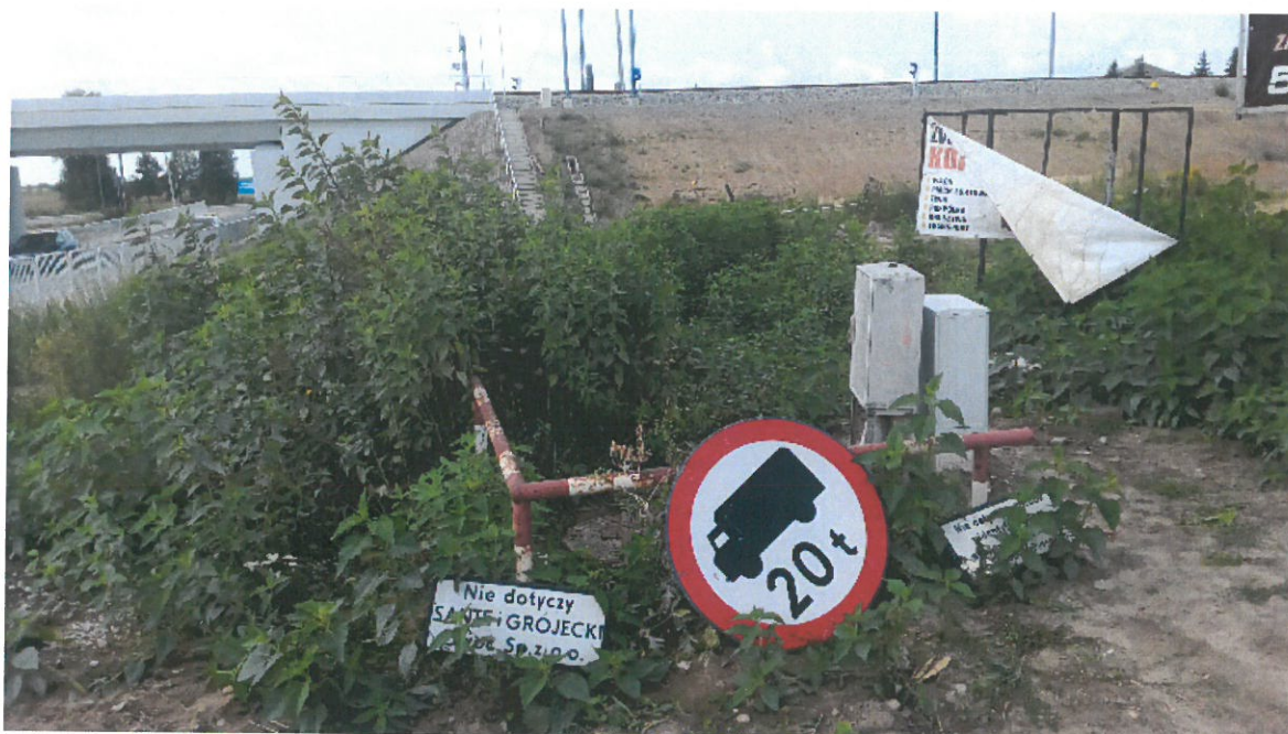
Zdjęcie nr 45 – Pompownia.
