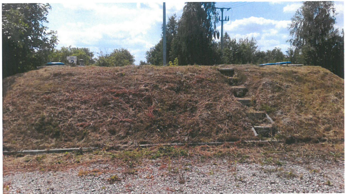
Zdjęcie nr 9 – Widok na studnie głębinowe.
