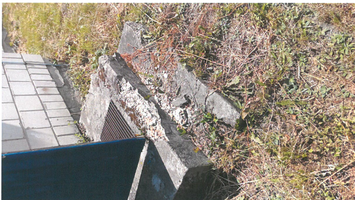
Zdjęcie nr 22 – Budynek SUW.
