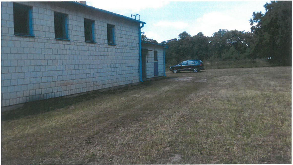
Zdjęcie nr 19 – Budynek SUW.
