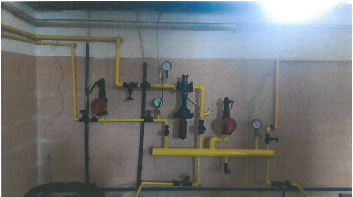
Zdjęcie nr 28 – System dystrybucji sprężonego powietrza.
