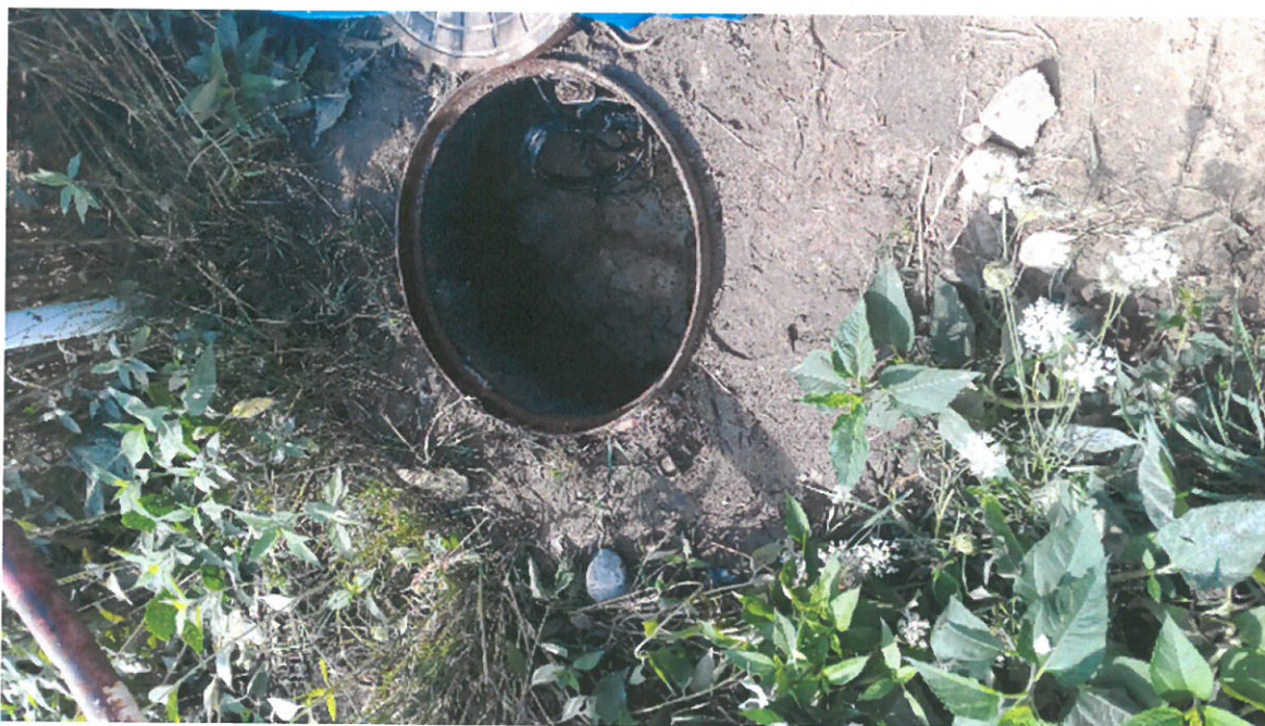
Zdjęcie nr 46 – Pompownia.
